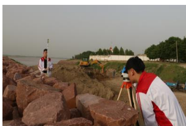
黄河堤防断面测量
